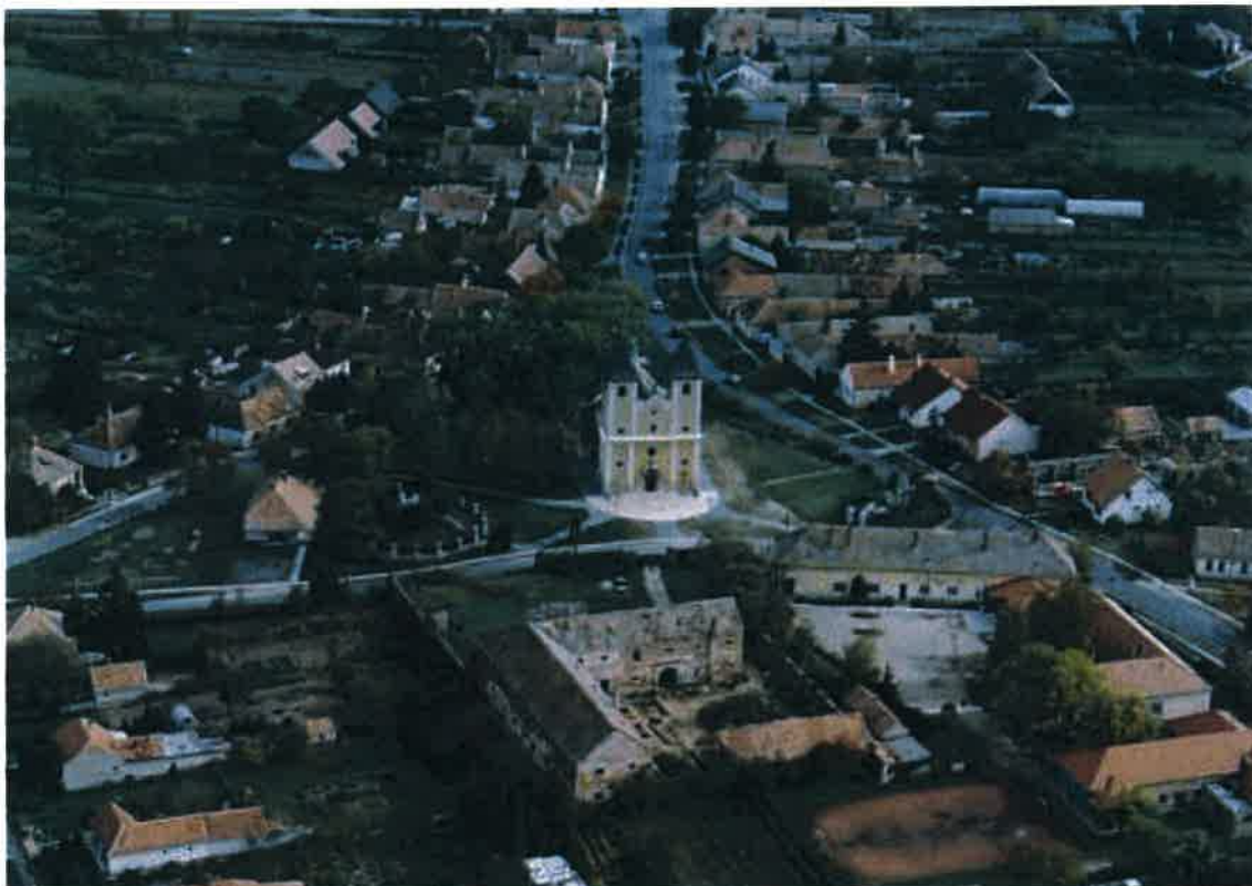
„Y” alakban elágazó főutcára felfűzött település, az „Y” torkolatánál a „szakrális háromszögben” a széplaki Hármashalom által a lakóházak fölé emelkedő kéttornyos templommal, emlékművekkel, velük szemben az általános iskolával és Széchényi Ferenc szülőházával, a kastéllyal
