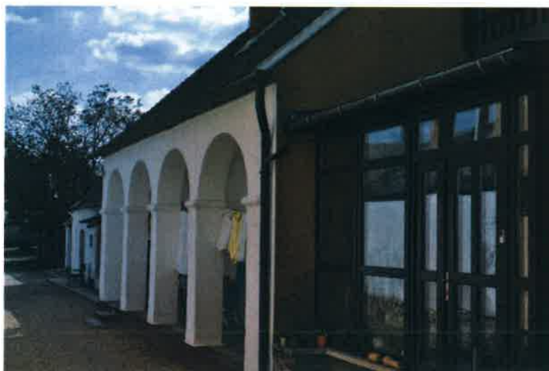
Nagy Lajos utca 52. lakóház hátsó traktusa 656hrsz.
