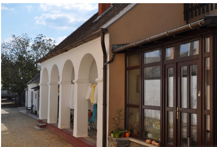
Nagy Lajos utca 52. lakóház hátsó traktusa 656hrsz.
